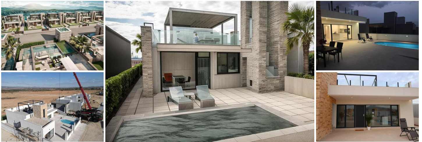
NYBYGGDA VILLOR I FUENTE ALAMO, MURCIA
