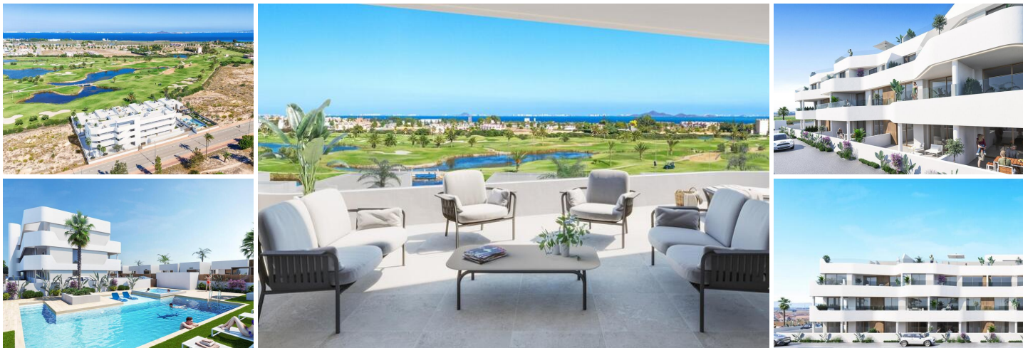
Nybyggt bostadskomplex i Los Alcazares
