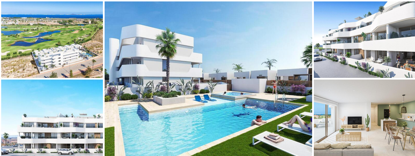
Nybyggt bostadskomplex i Los Alcazares
