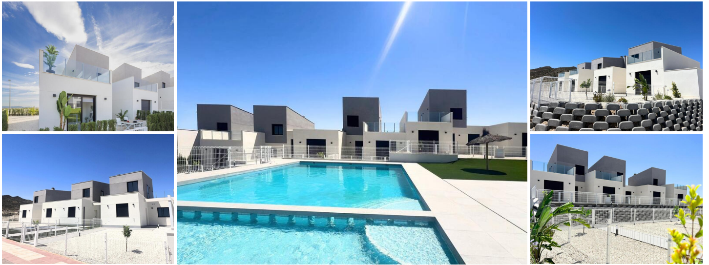
NYBYGGDA RADHUS I ALTAONA GOLF RESORT, MURCIA
