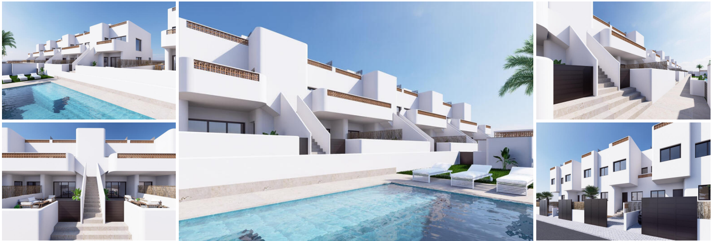
Бунгало нового строительства в Долорес
