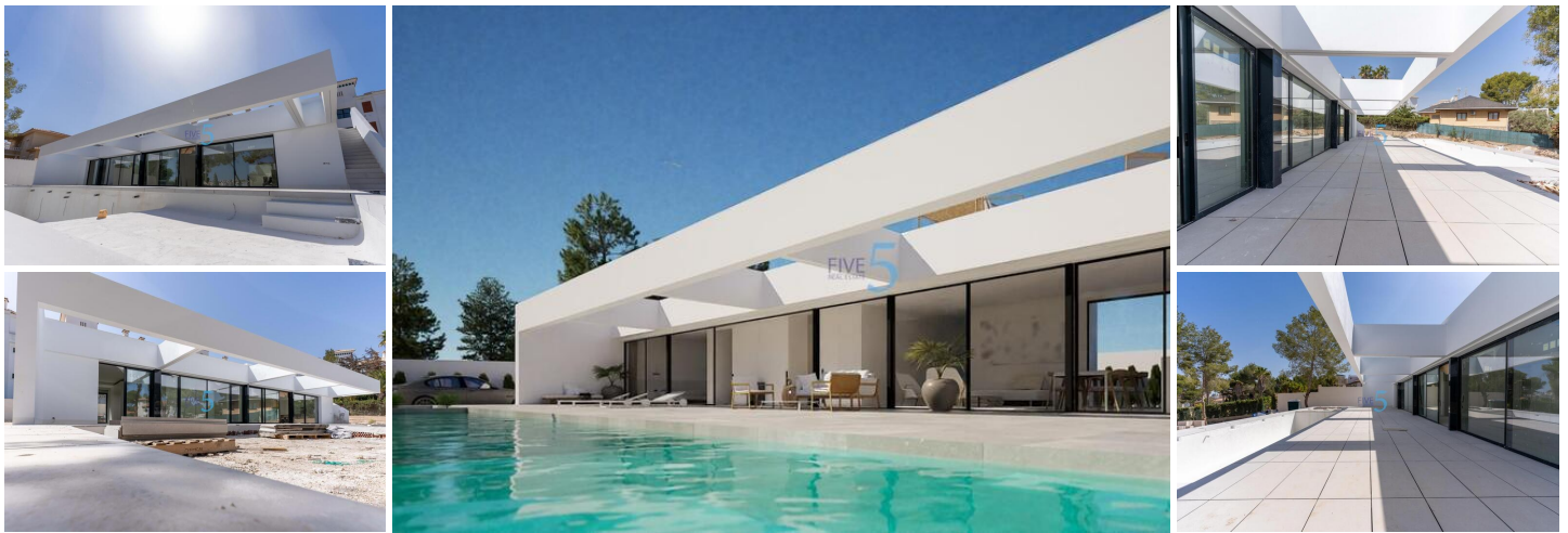
NEW BUILD VILLA IN LAS FILIPINAS
