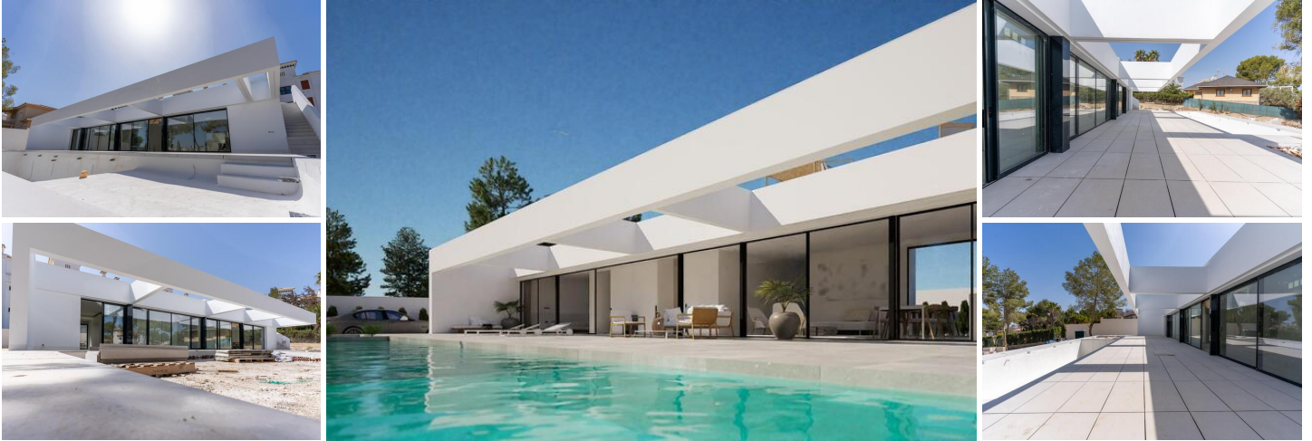
NEW BUILD VILLA IN LAS FILIPINAS
