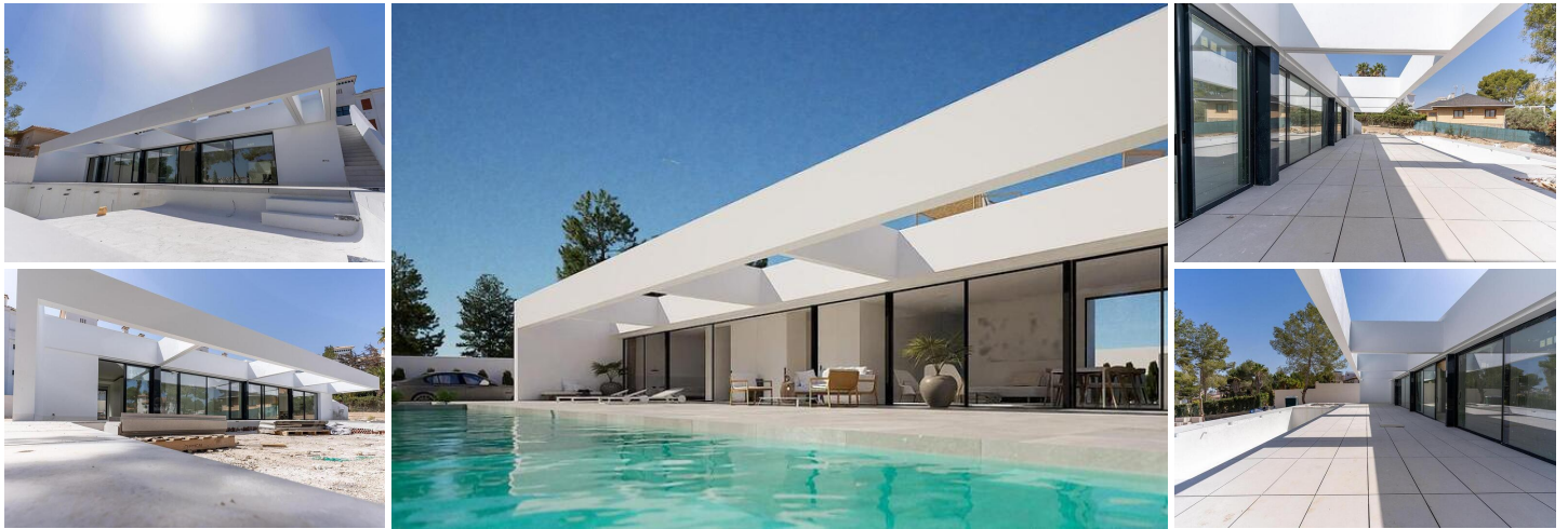
NEW BUILD VILLA IN LAS FILIPINAS
