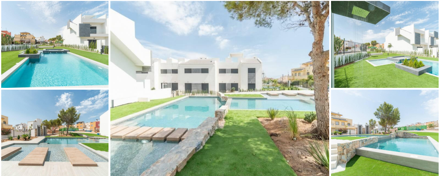
New residential complex at Los Balcones(Torrevieja)
