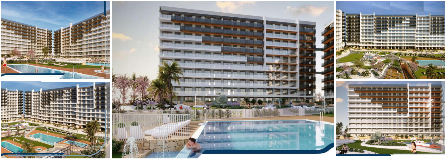
Nieuwbouw wooncomplex in punta prima
