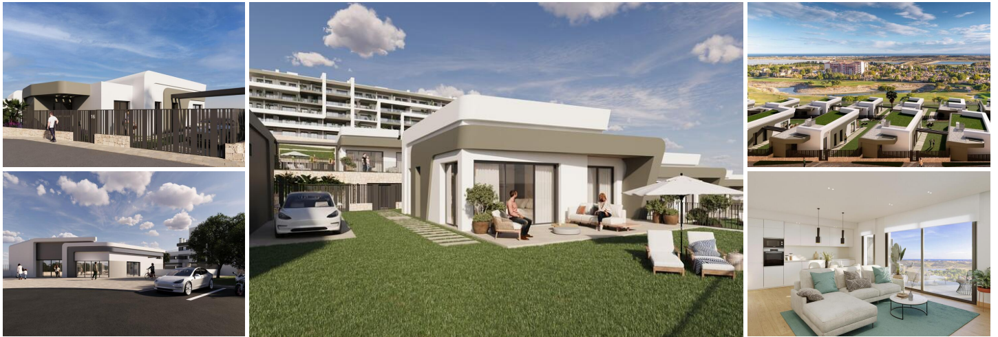
Nieuwbouw wooncomplex bij mutxamel
