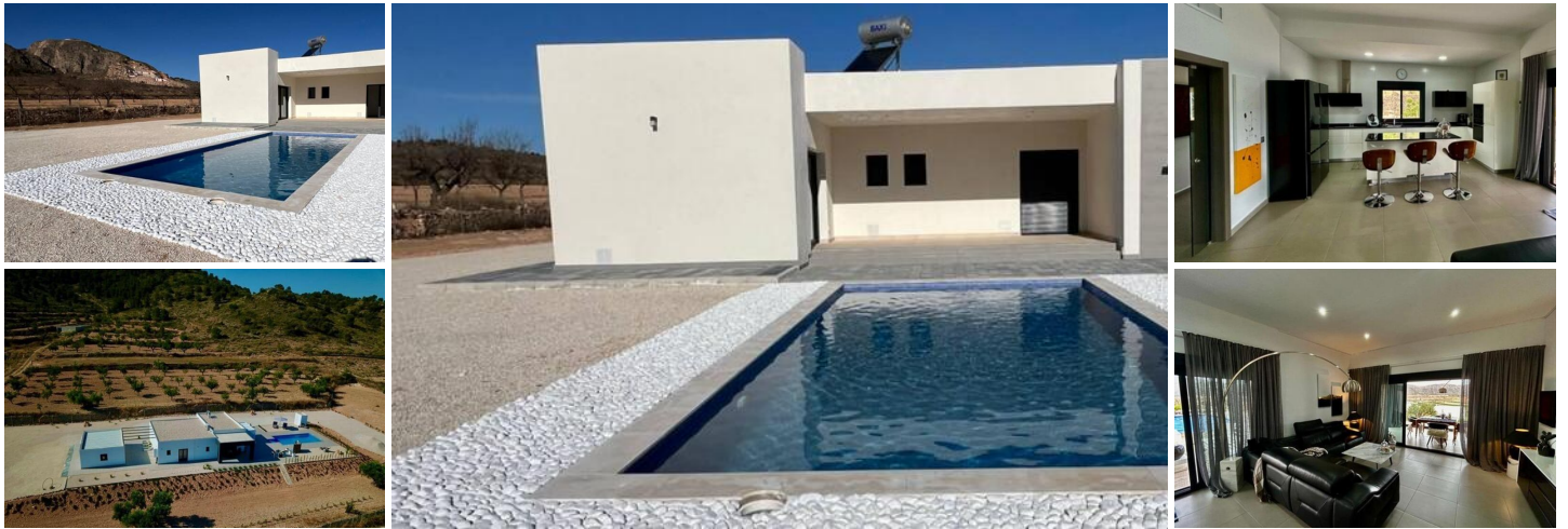
NIEUWBOUW VILLA IN HONDON DE LAS NIEVES
