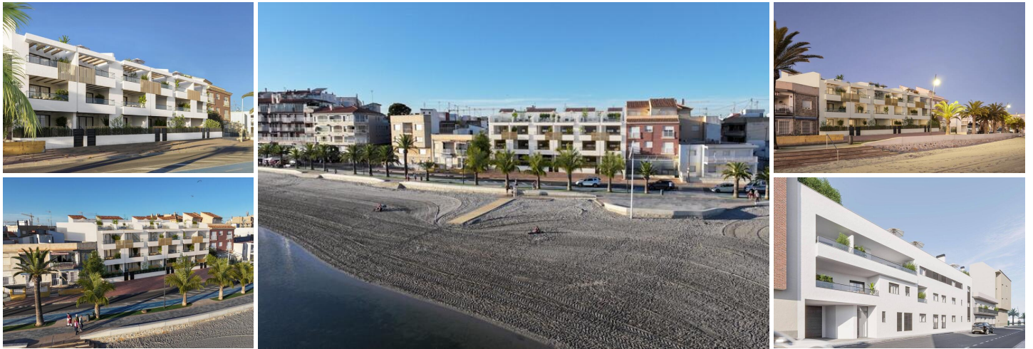
Nieuwbouw villa in san pedro del pinatar
