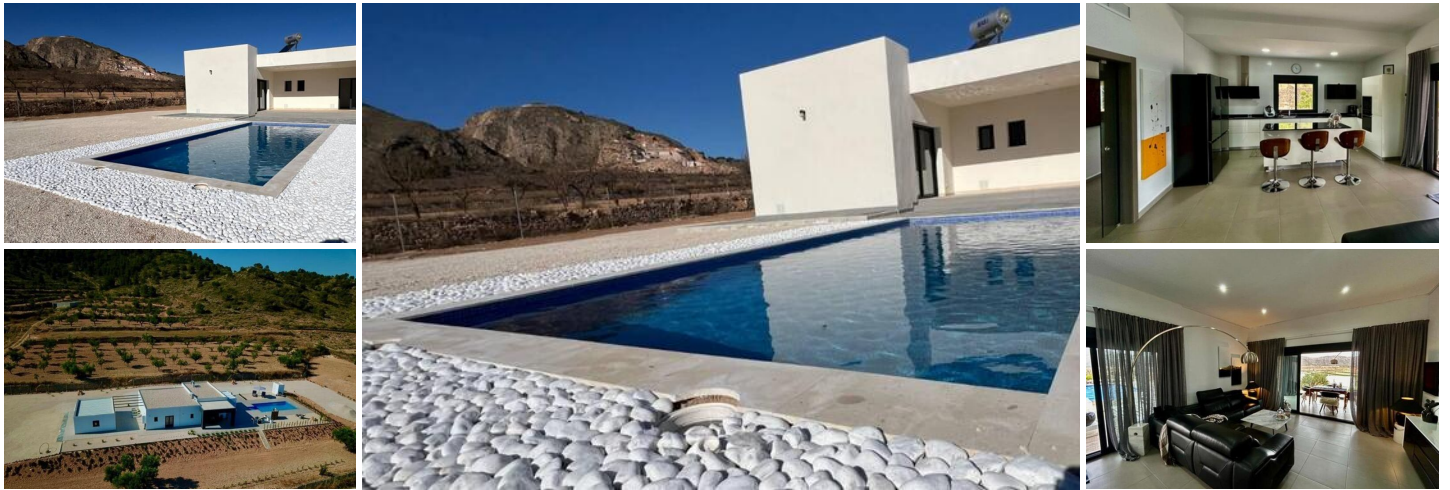
NIEUWBOUW VILLA IN HONDON DE LAS NIEVES
