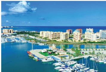
NIEUWBOUW VILLA'S IN LOS ALCAZARES
