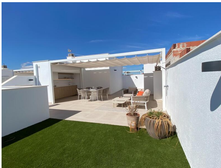
Nieuwbouw Bungalow Wooncomplex in Pilar de la Horadada
