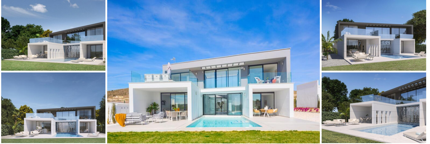
NIEUWBOUW VILLA'S IN ALTAONA GOLF RESORT, MURCIA
