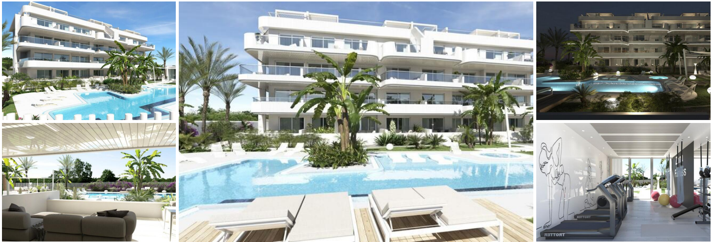
Complexe résidentiel neuf à lomas de cabo roig
