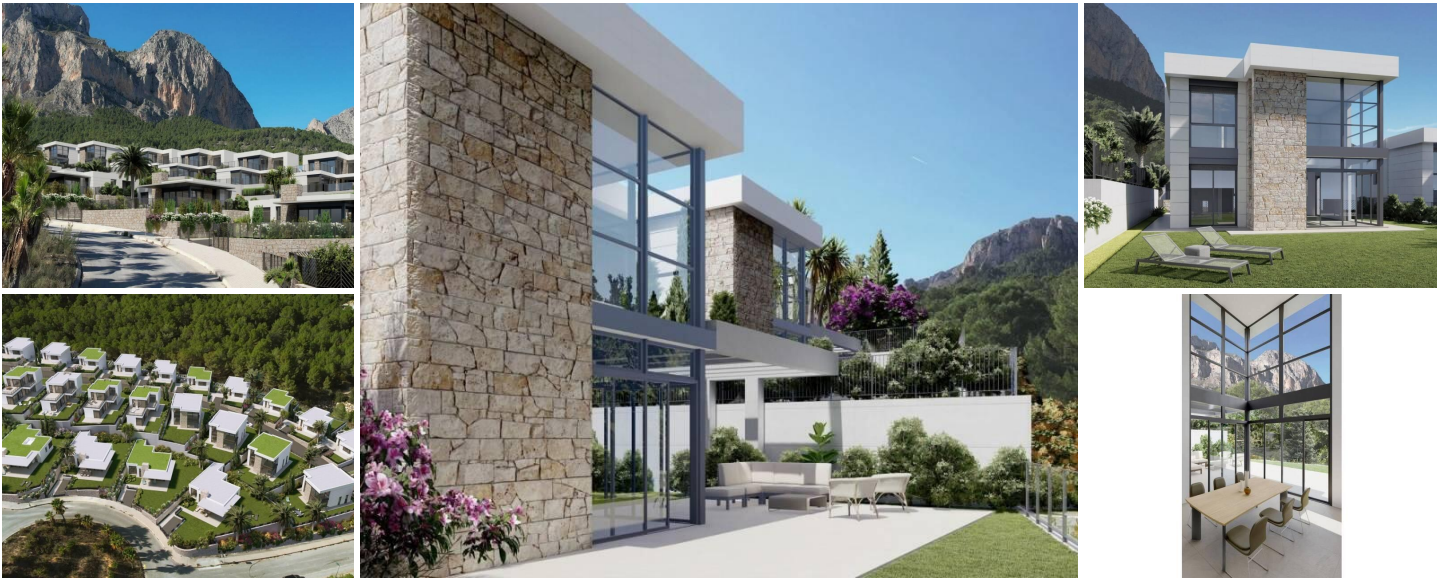
Villas neuves à Polop, Alicante
