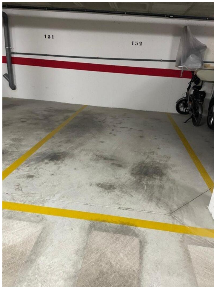
parking souterrain au bloc 4 du golf Valentino à Villamartin
