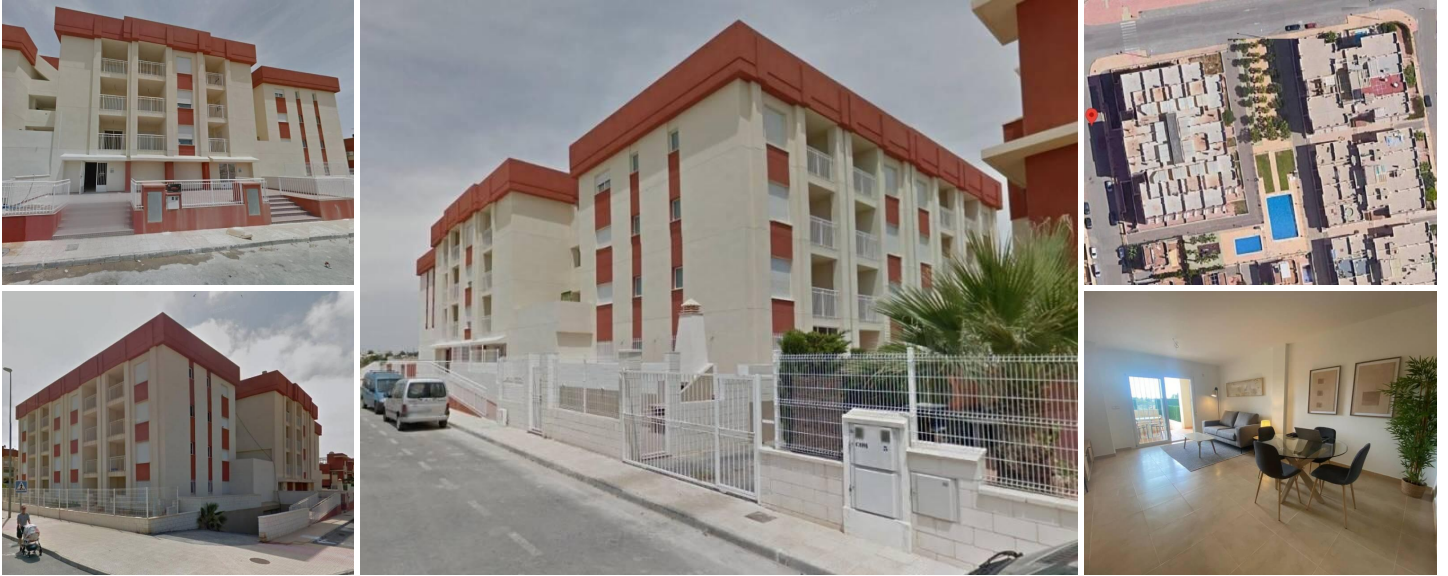
Complejo Residencial Regenerado en Lomas de Cabo Roig - Apartamentos Reformados
