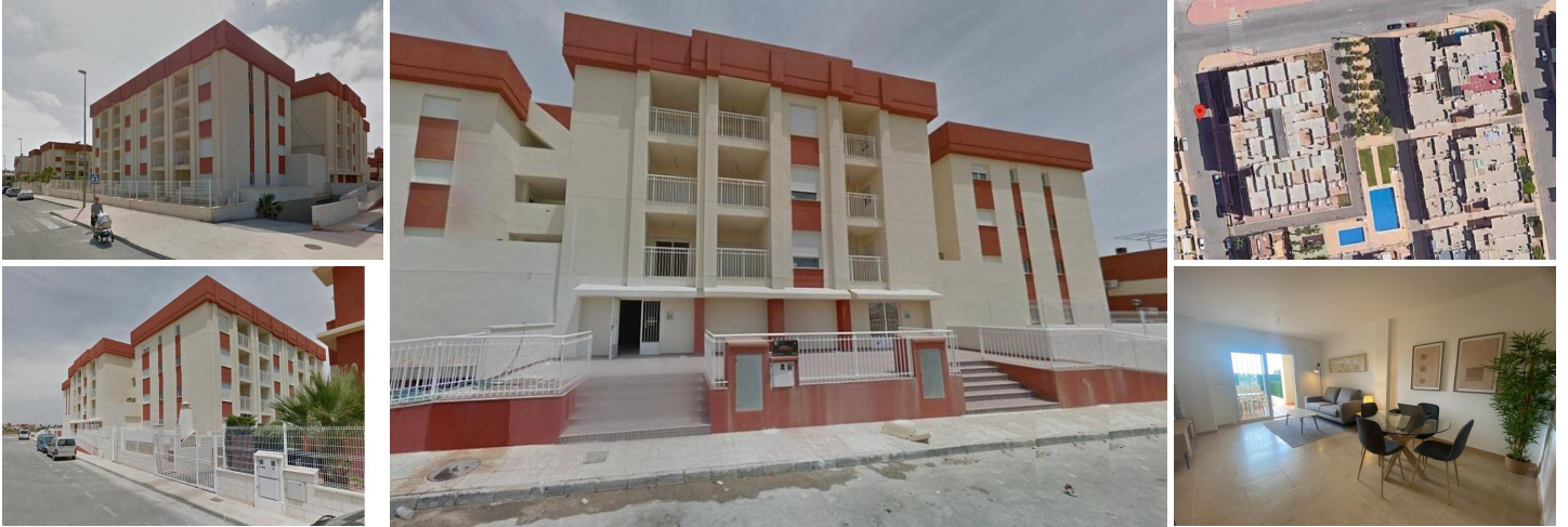
Complejo Residencial Regenerado en Lomas de Cabo Roig - Apartamentos Reformados
