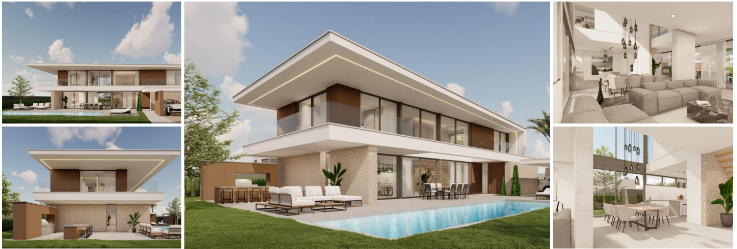
Villa de obra nueva en cabo roig
