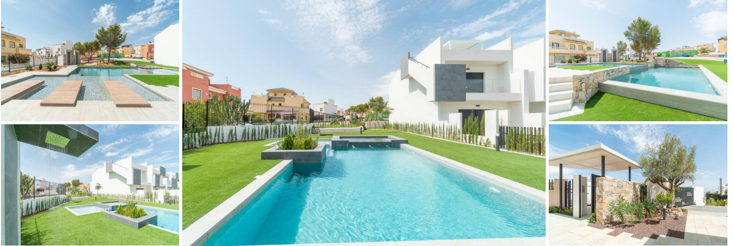
Nuevo conjunto residencial en Los Balcones (Torrevieja)
