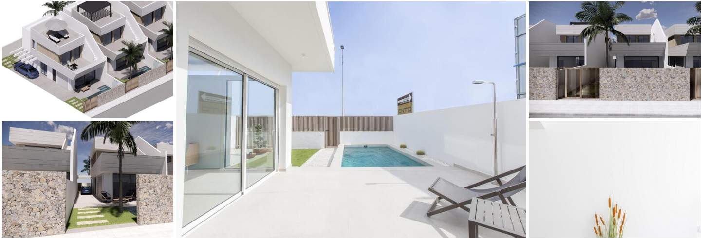
Villas de obra nueva en san javier
