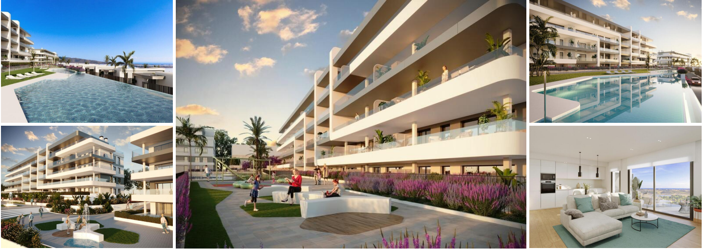
COMPLEJO RESIDENCIAL DE OBRA NUEVA CERCA DE MUTXAMEL
