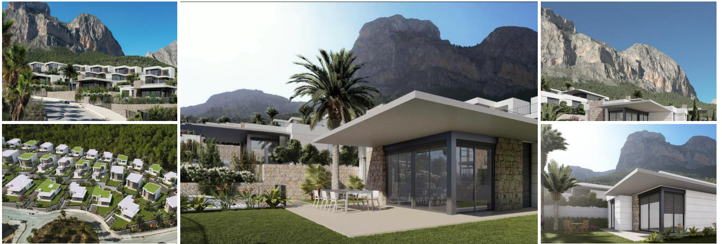
Chalets de Nueva Construcción en Polop, Alicante
