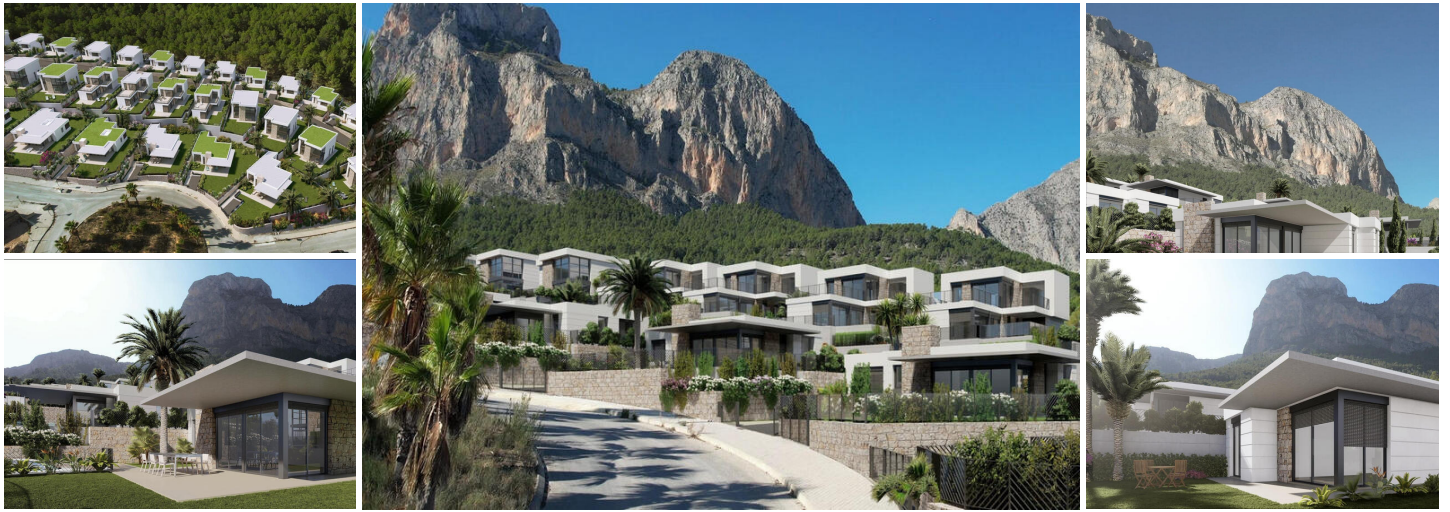
Chalets de Nueva Construcción en Polop, Alicante
