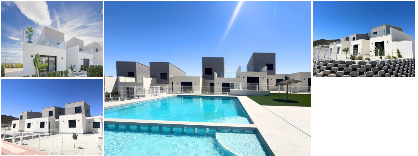
ADOSADOS DE OBRA NUEVA EN ALTAONA GOLF RESORT, MURCIA
