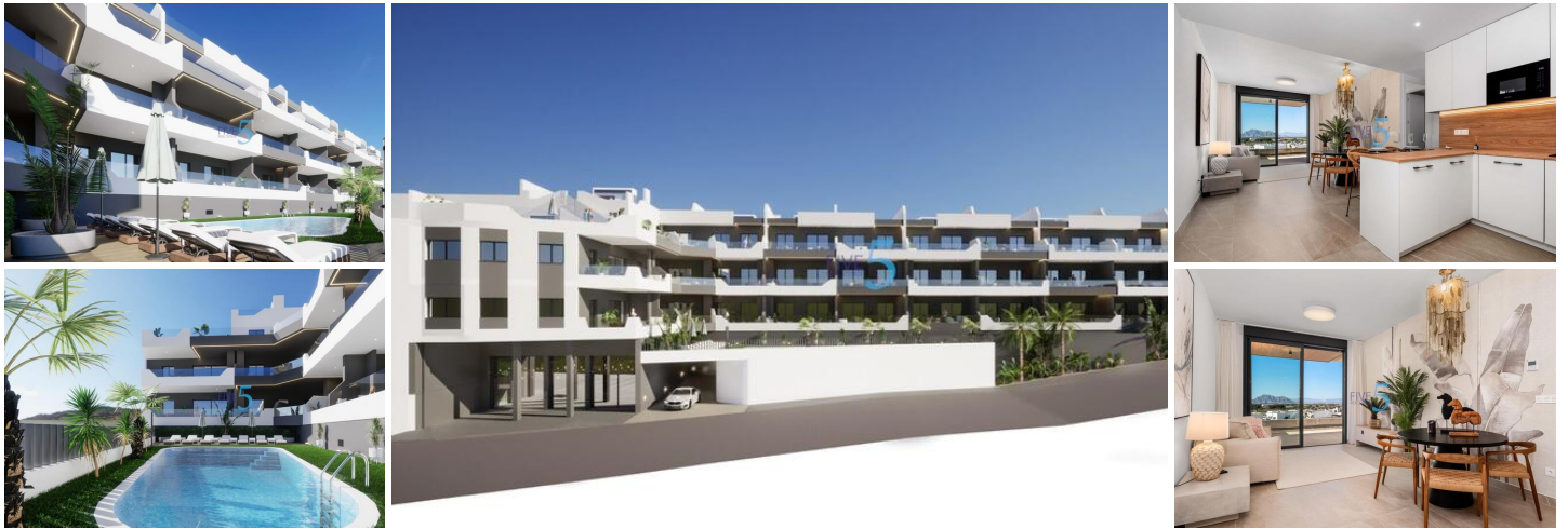
COMPLEJO RESIDENCIAL DE OBRA NUEVA EN BENIJOFAR
