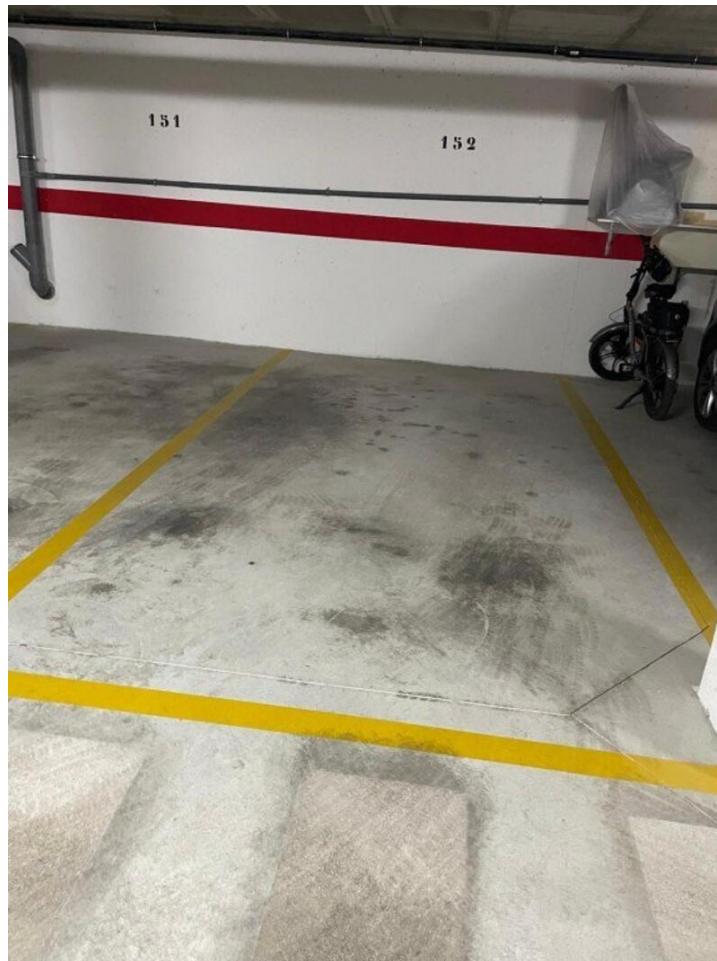
Aparcamiento subterráneo en Valentino Golf bloque 4 en Villamartin
