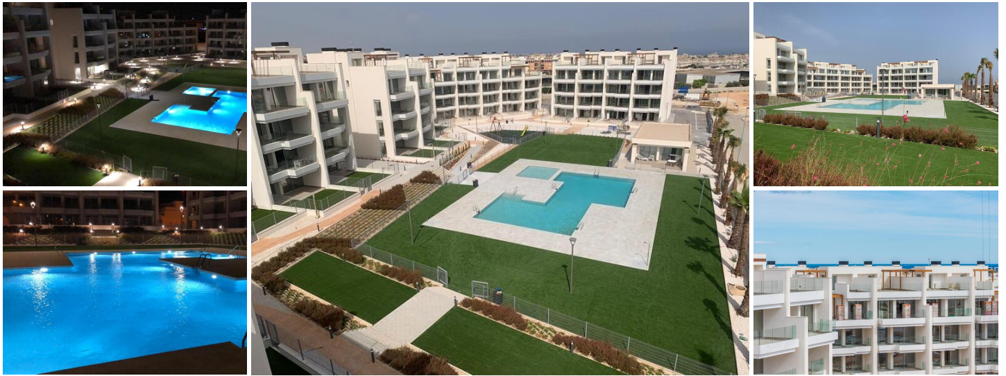
COMPLEJO RESIDENCIAL DE OBRA NUEVA EN VILLAMARTIN
