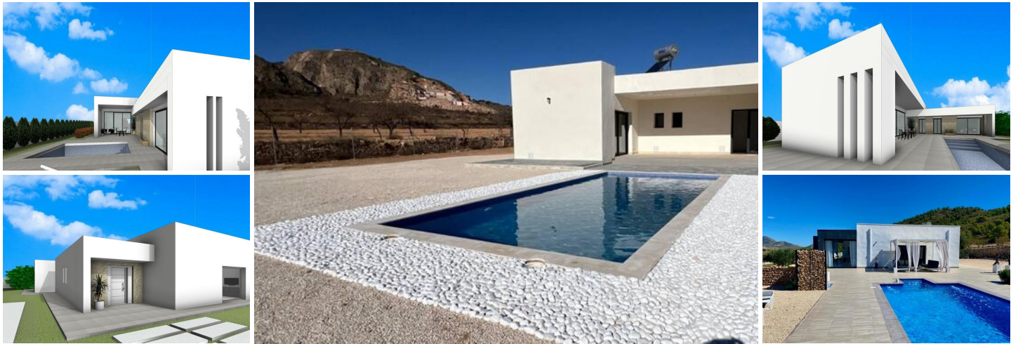
VILLA DE OBRA NUEVA EN ALBANILLA, MURCIA
