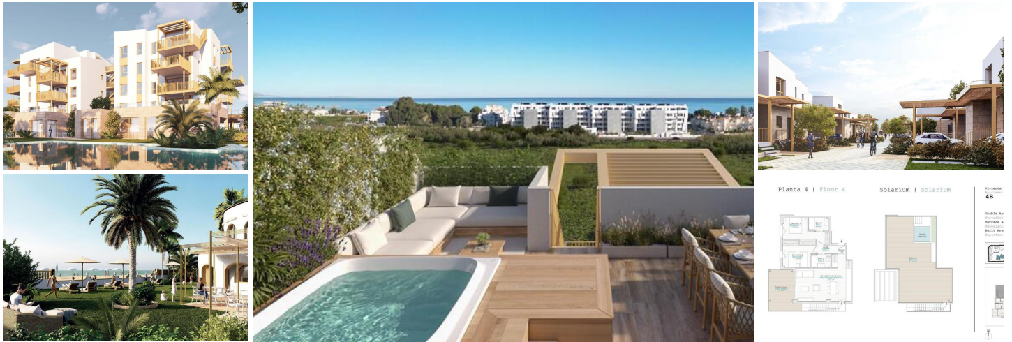
NEUBAU WOHNANLAGE IN EL VERGEL
