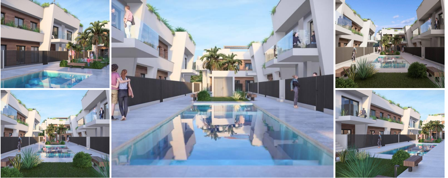
Neubau Häuser in Torre-Pacheco, Costa Cálida
