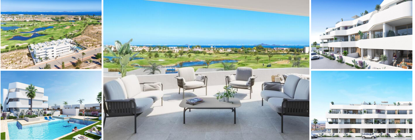
Neubau-Wohnanlage in Los Alcazares
