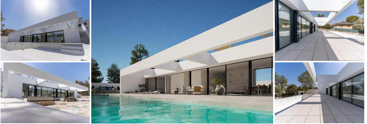
NEW BUILD VILLA IN LAS FILIPINAS
