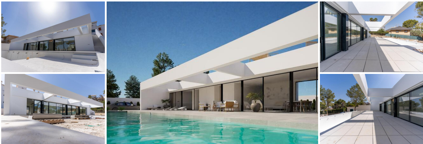
NYBYGGET VILLA I LAS FILIPINAS
