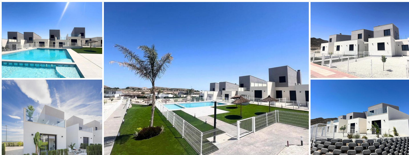
NYBYGGEDE RÆKKEHUSE I ALTAONA GOLF RESORT, MURCIA
