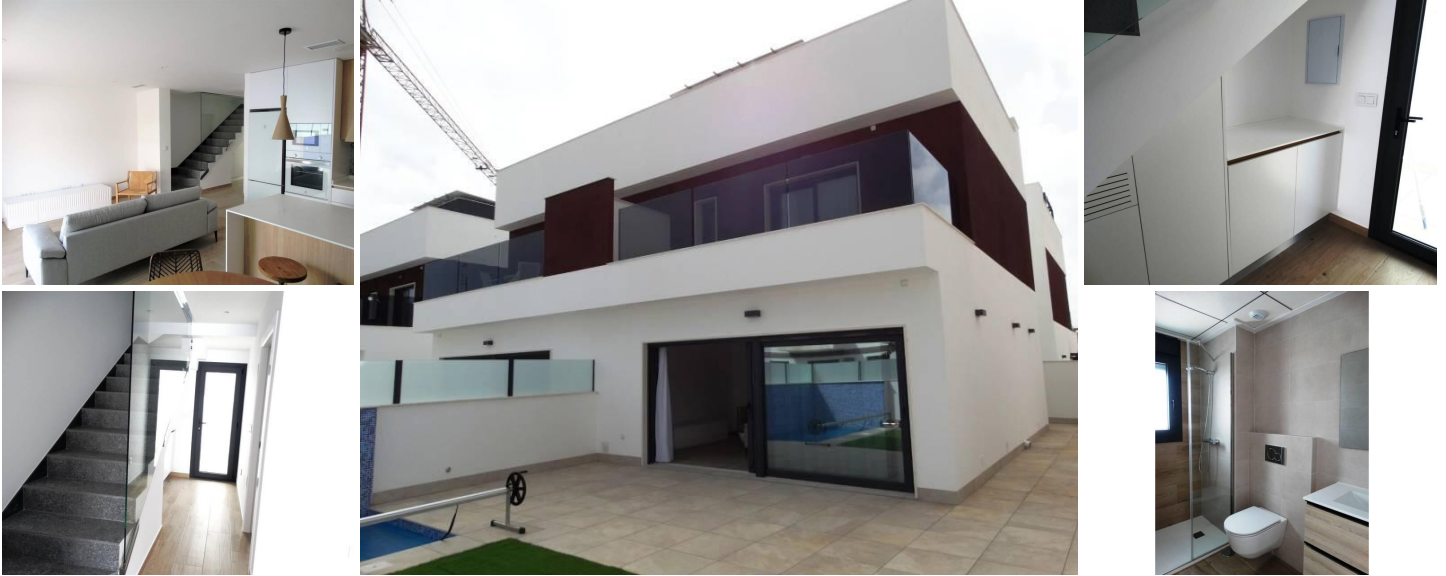
NYBYGGEDE PARCELHUSE I SANTIAGO DE LA RIBERA
