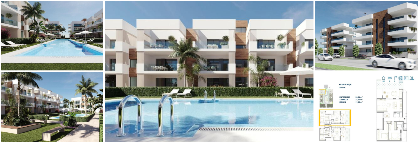
NYBYGGEDE BOLIGER I SAN PEDRO DEL PINATAR
